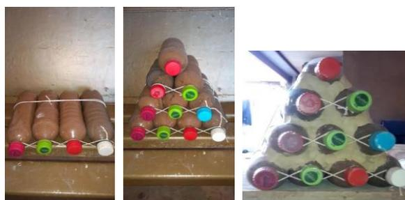
**Figura 2.** Processo de amarração das garrafas e rejunte feito com argila. Fonte: Dos autores. 2019.
